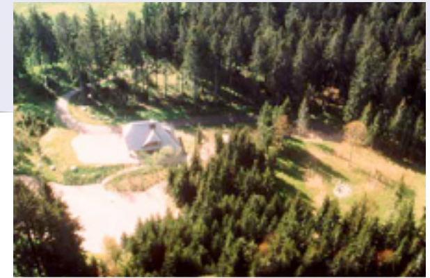
Blick von oben auf die Hütte und das Gelände
