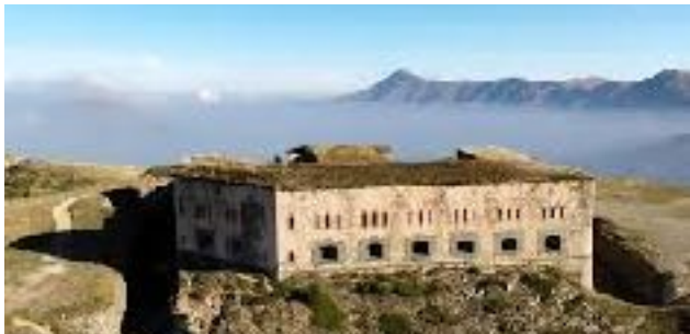
Fort Central am Colle di Tenda
